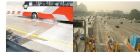
SYSTEME AUTOMATIQUE D'ARROSAGE (SAUMURE)
